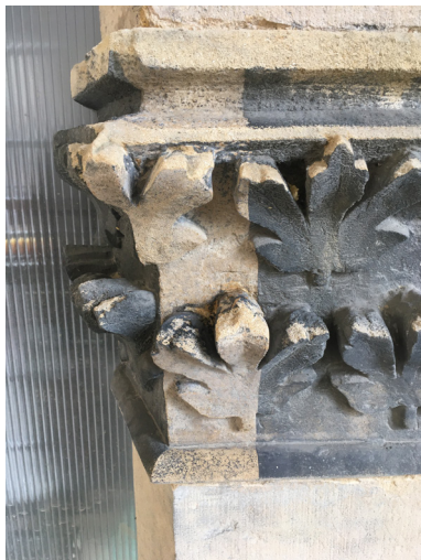
Chapiteau du triforium en cours de nettoyage - © DRAC Grand Est
