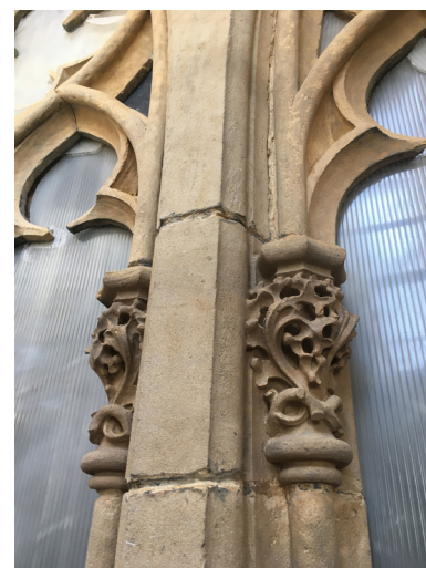
Détail des chapiteaux après nettoyage - © DRAC Grand Est
